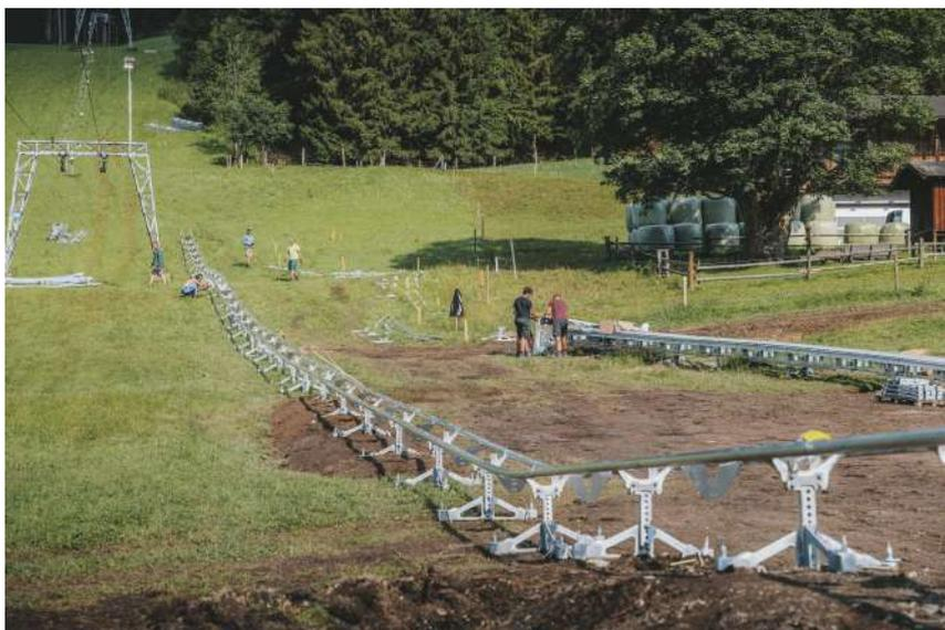
Die Bahn wird großteils nur mit Erdanker befestigt
